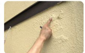
外壁の浮きやハガレをチェック。
